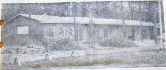
Paviljongen är 25 meter lång och rymmer hall, tre omklädningsrum, duschrum, pentry, kontorslokaler och samlingssal.
